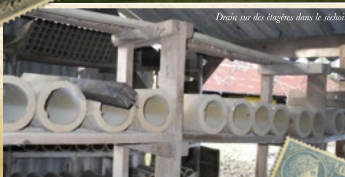
Hangar principal de la tuilerie avec les cheminées des 2 fours
